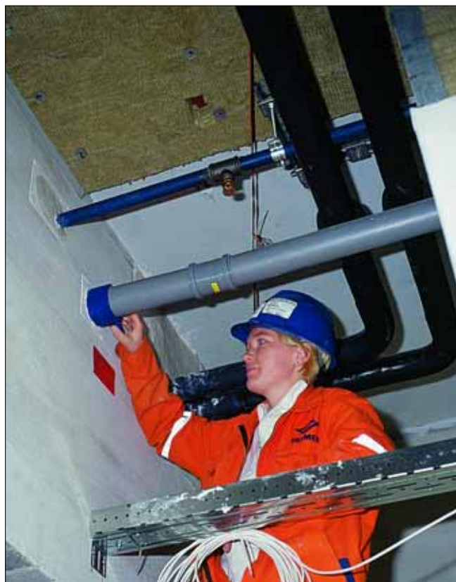
Utenpåliggende Glava rørmansjett montert rundt plastrør som er støpt inn i FS-GPG masse i vegglivet
