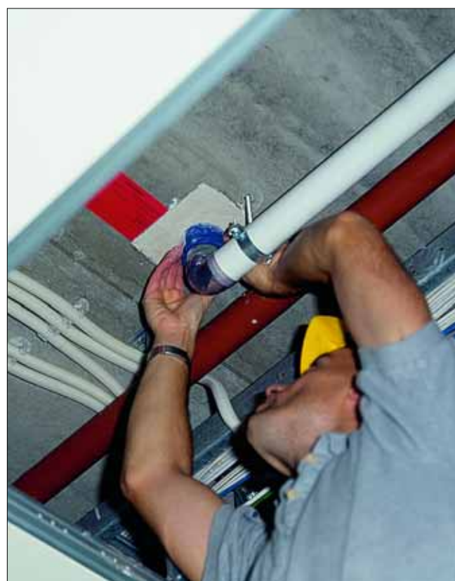
Utenpåliggende Glava rørmansjett montert rundt plastrør som er støpt inn i FS-GPG masse i dekke
