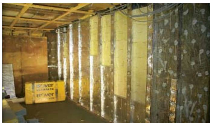
Isolering af motorrum med Isover ULTIMATE. Materialet folder sig perfekt ud mellem spanterne og lukker helt tæt til.
