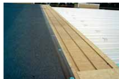
Figur 1. Låglutande tak, snitt och ett exempel på ett tak med spårad isolering för ventilation.
