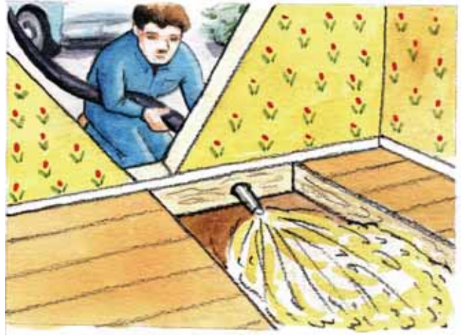
Innblåsing i eksisterende bjelkelag
