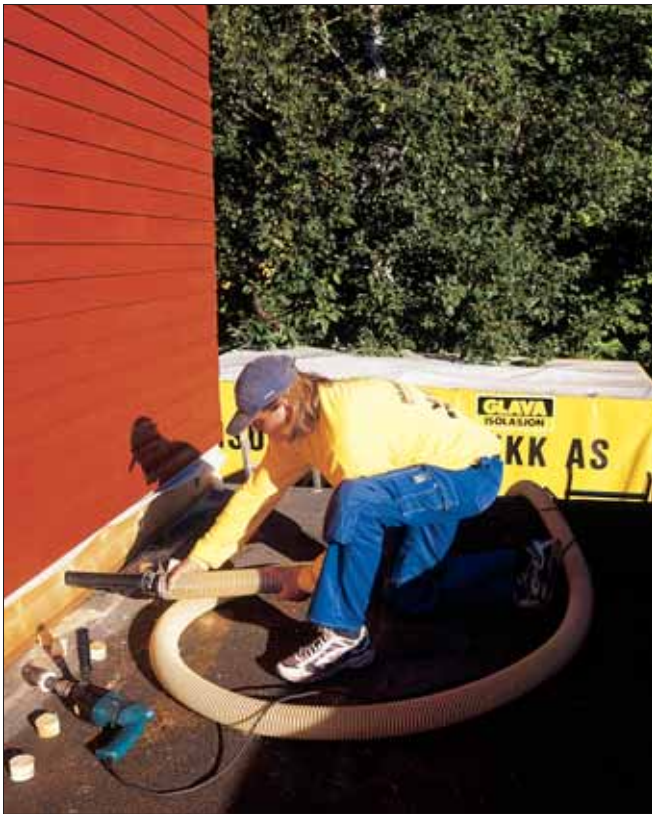
Innblåsing i eksisterende bjelkelag
