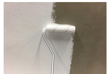
Påføring av Mineralux 8270 kan utføres med rull, kost eller sprøyte. Anbefalt to sjikt
