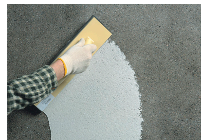
Påføring av REP 990 kan utføres med brett, kost eller sprøyte i to sjikt.
