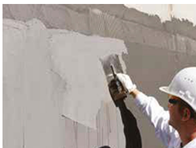
Lag nr 2 vanntetting utført med tannet sparkel
