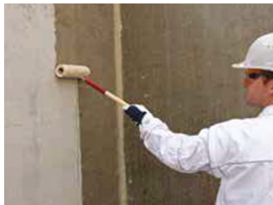
Priming av underlag med Forvanning/prim 801 eller 4716
