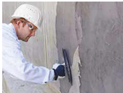
Poretetningslag, skrapsparkling
