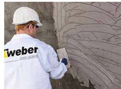
Første lag vanntetting utført med tannet sparkel
