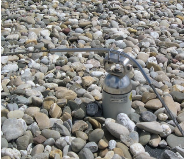
Fig. 33 Eksempel på festepunkt for sikkerhetsline
