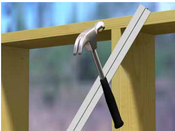
Fig. 31 Avstivningsstag bankes inn i slissen
