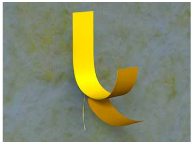
Fig. 42 Reparasjon av rift i dampsperre med dampsperretape
