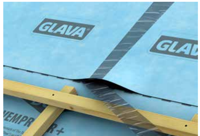
Fig. 8 Fjerning av dekkfolie på klebekanter
