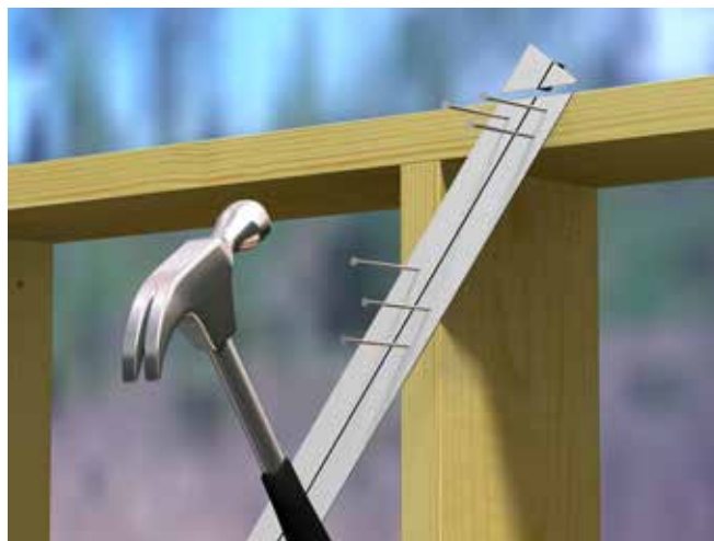
Fig. 32 Spikring av avstivningsstag
