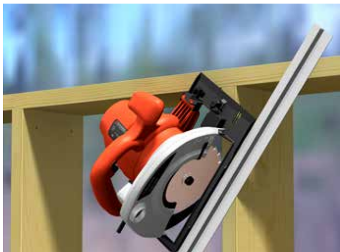
Fig. 30 Slissing i stenderverk for avstivningsstag
