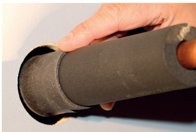
Fest brannpakningen med elektrostrips/tape og dytt pakningen inn i konstruksjonen
