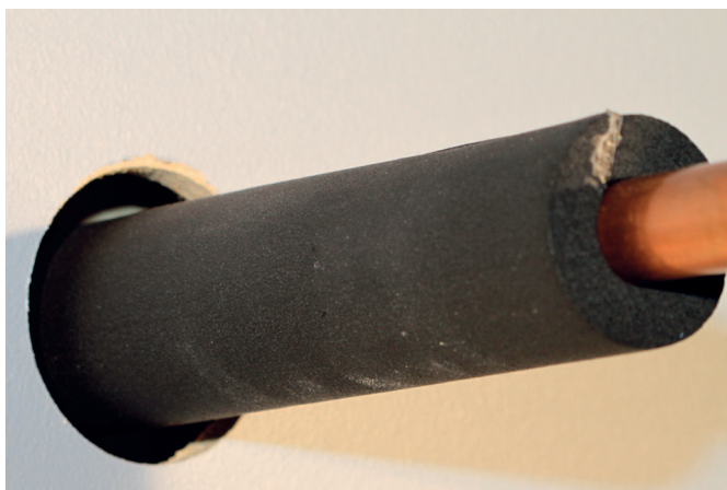
Før isolasjonen gjennom konstruksjonen
