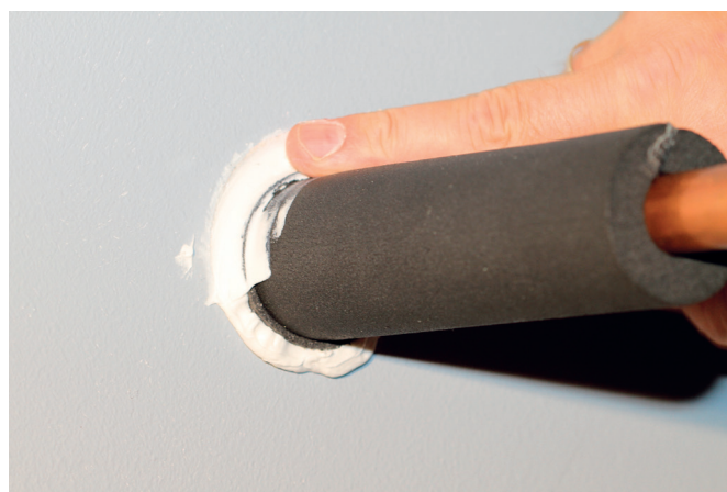
Jevn ut fugemassen med fingeren. Konstruksjonen er ferdig!
