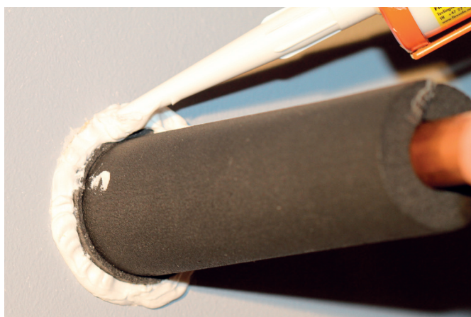
Tett åpningen mellom brannpakningen og utsparringen med GLAVA® Akryl fugemasse eller GLAVA® GPG masse
